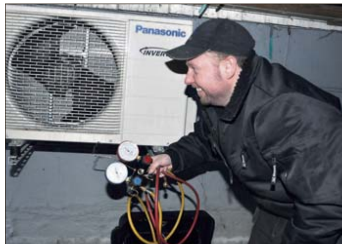
PUMPER VARME: Montering og service av varmepumper har blitt en betydelig del av Pedersens oppdrag.
